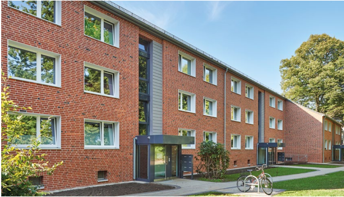
Blick auf einen Teil unserer energetisch modernisierten Hans-Schwenkel-Wohnanlage in Langenhorn. Seit 2017 modernisieren wir Zug um Zug unsere 477 Wohnungen energetisch – und reduzieren dadurch unsere CO 2 -Emissionen immer weiter
