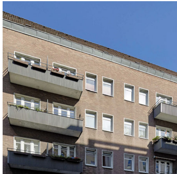
Nach dem Umbau kaum wiederzuerkennen: die Fassade der Ditmar-Koel-Straße 32–34.
