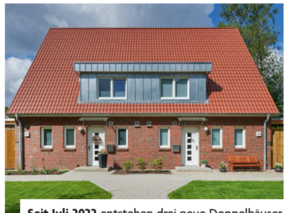
Seit Juli 2022 entstehen drei neue Doppelhäuser in der Matthias-Strenges-Siedlung.
