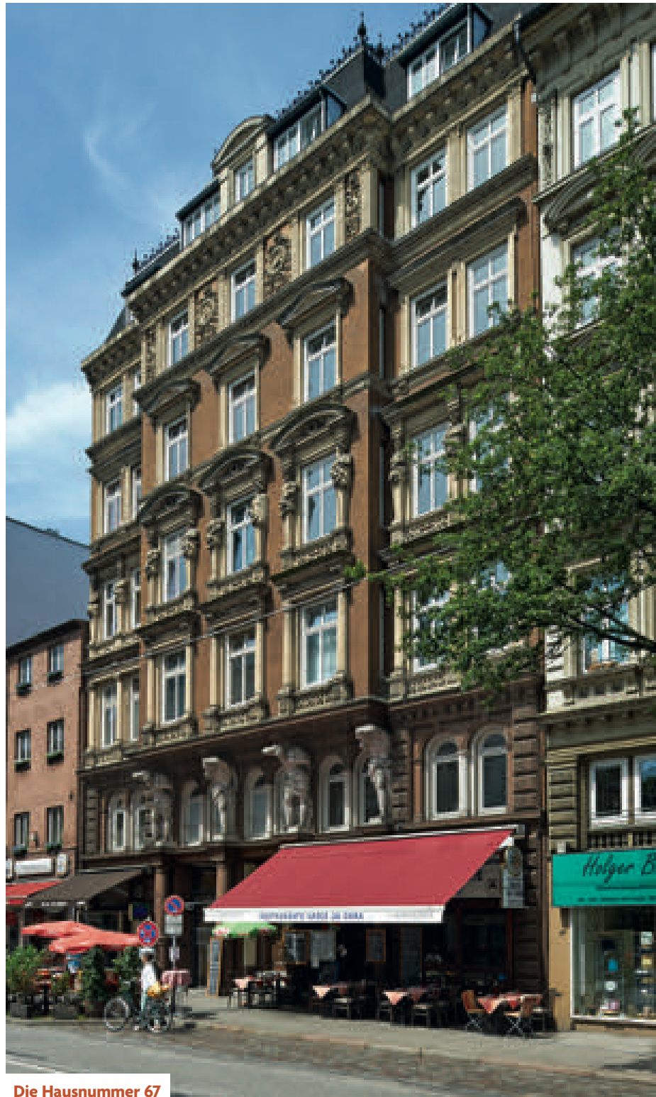
Die Hausnummer 67 Die Vorderfront wird derzeit einer umfangreichen Restauration unterzogen.
