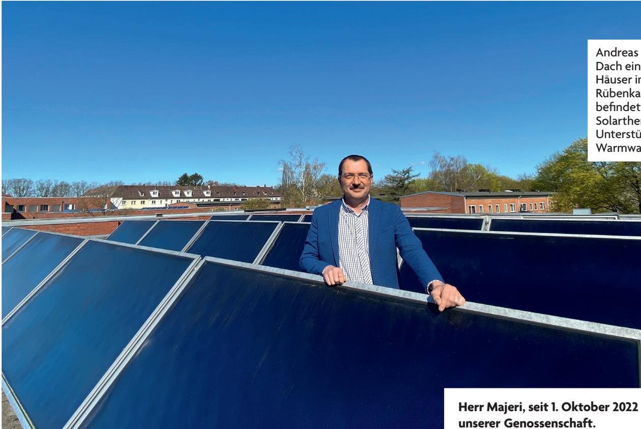
Andreas Majeri auf dem Dach eines unserer Häuser im Quartier Rübenkamp. Dort befindet sich eine Solarthermieanlage zur Unterstützung der Warmwasserbereitung.
